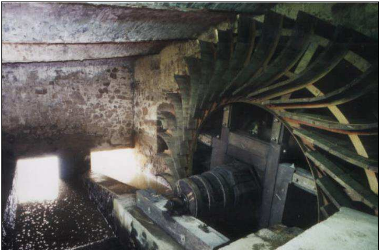
Abbildung 18: Wasserrad der Riegel-Mühle Nechern
